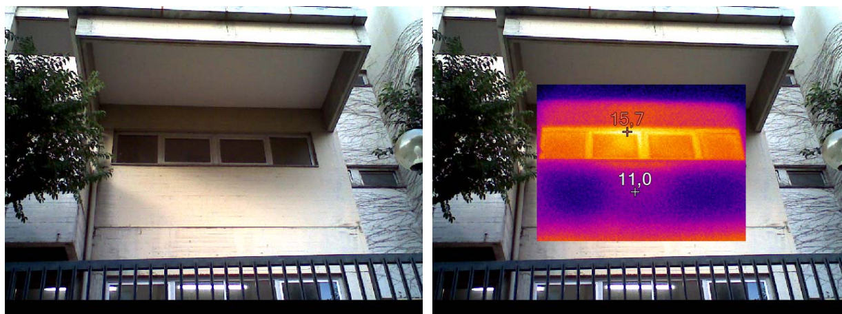
Figura 4.6 – Rilievo termografico dei serramenti
