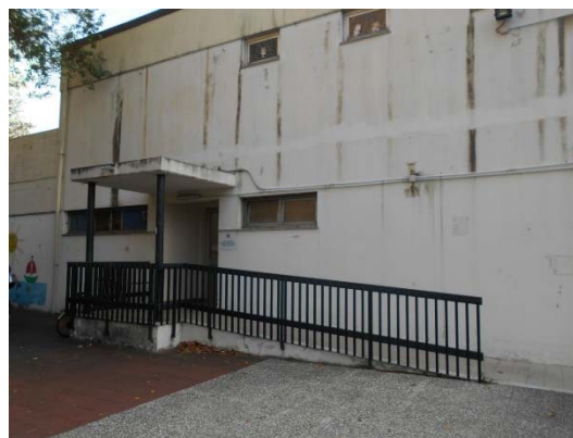
Figura 4.1 - Particolare della facciata principale d'ingresso (lato nord)
