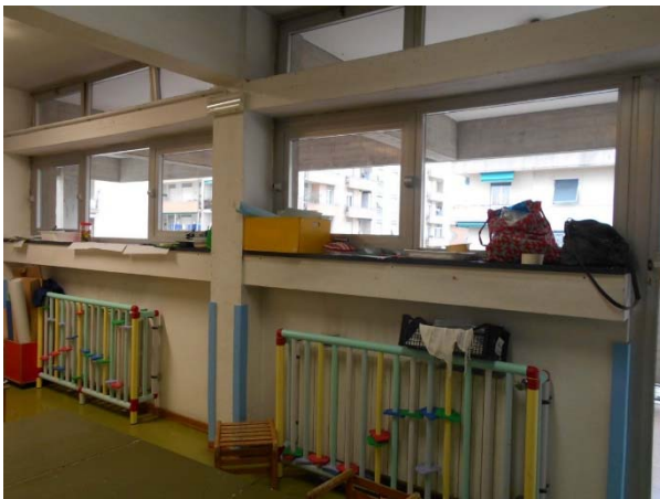
Figura 4.4 - Particolare dei serramenti
