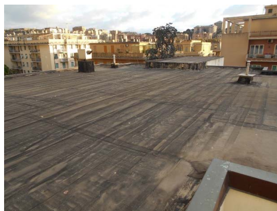
Figura 8.3 - Particolare della copertura
