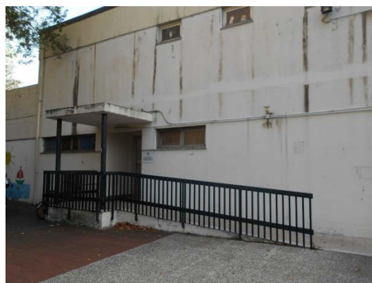
Figura 8.1 - Particolare di una parete esterna
