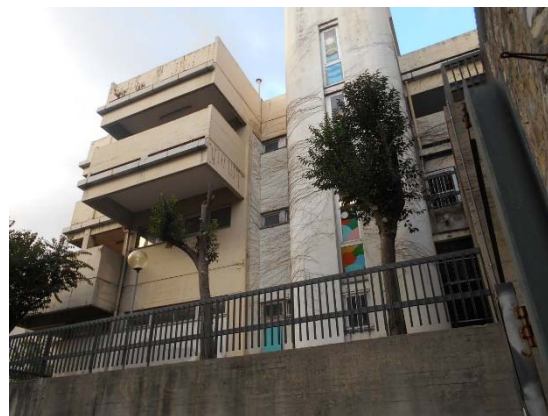
Figura 1.1 - Vista della facciata esposta a Sud
