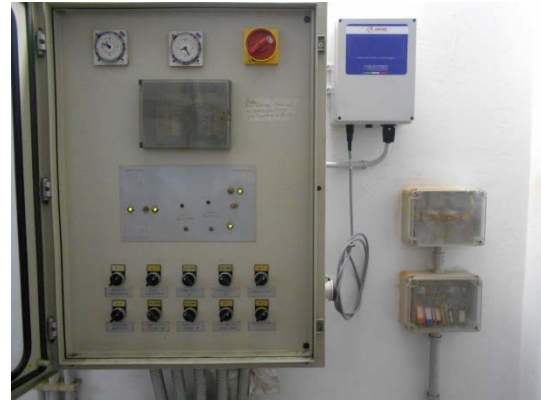
Figura 4.9 – Dispositivo per la telegestione
