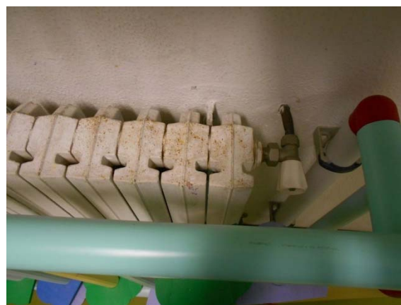
Figura 4.7 - Particolare di un radiatore in ghisa
