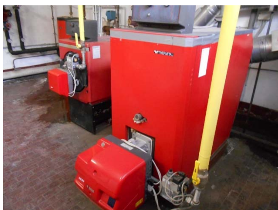
Figura 4.12 - Particolare della caldaia per riscaldamento
