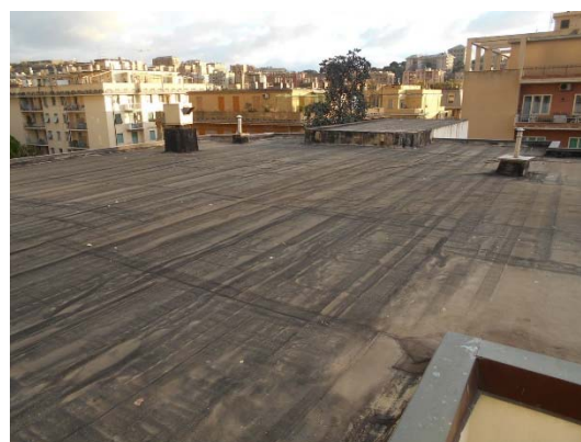
Figura 8.12 - Particolare della copertura dove installare l’impianto
