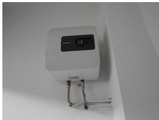
Figura 4.14 - Particolare di un boiler elettrico per la produzione di acqua calda sanitaria
