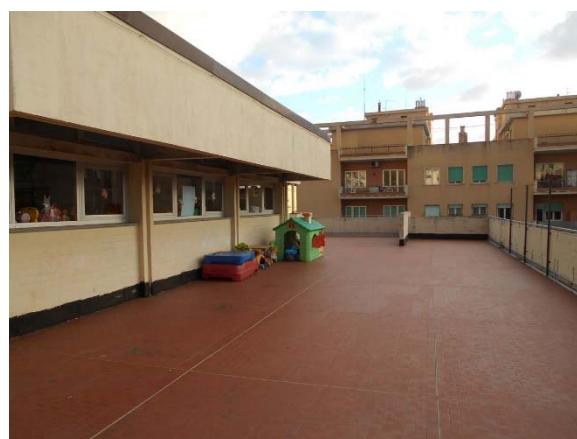
Figura 4.2 - Particolare di una terrazza del primo piano
